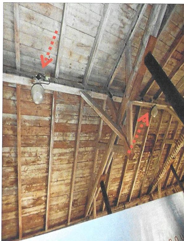
Foto č. 21 - Sklad a zázemí (lokalita 2a). Podložky pod elektroinstalačními prvky uvnitř objektu.
