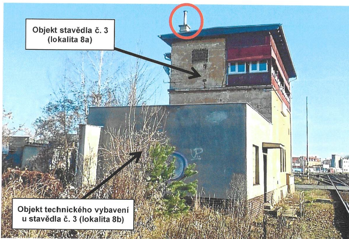
Foto č. 31 – Celkový pohled na objekty lokality 8. Azbestocementová roura a krycí stříška jako ukončení komínového nástavce.
