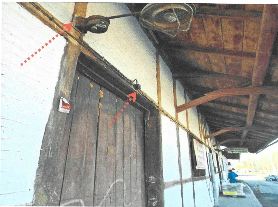
Foto č. 23 - Sklad a zázemí (lokalita 2b). Podložky pod elektroinstalačními prvky vně objektu.
