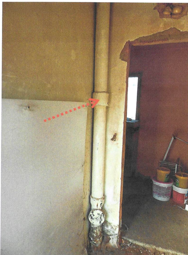
Foto č. 27 - Kanceláře (lokalita 3), vstupní prostor. Azbestocementové roury pravděpodobně jako odvětrávací potrubí.
