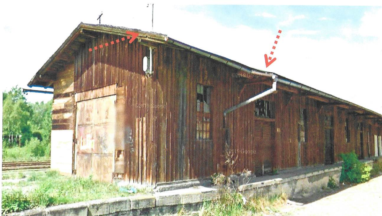
Foto č. 19 - Sklad a zázemí (lokalita 2a). Asfaltové pásy jako střešní krytina.
